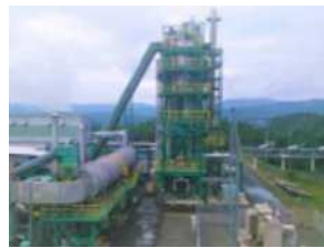
バイオマス発電所
