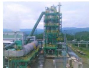
バイオマス発電所
